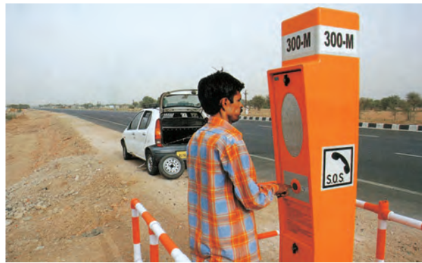
चित्र 7.10 – राष्ट्रीय राजमार्ग-48 पर एक आपातकालीन कॉल बॉक्स
